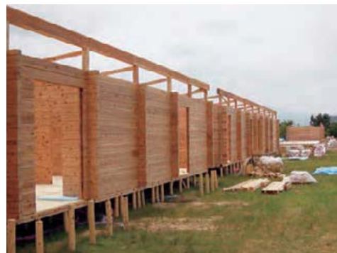
福島県本宮市に建設中の、県内産の木材を利用した応急仮設住宅
