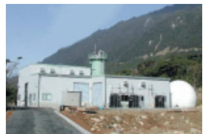
有機系廃棄物の複合資源化 システムパイロットプラント (鹿児島県屋久町)
