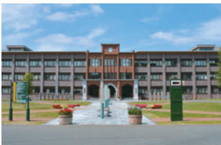
総合研究棟I号館
