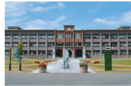
総合研究棟I号館
