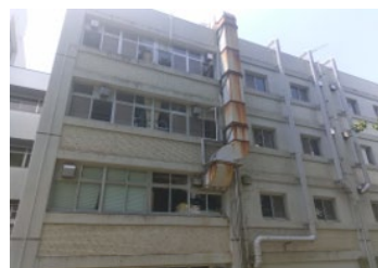
腐食して破損・落下の危険性が高い排気ダクト
