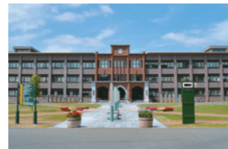
総合研究棟I号館
