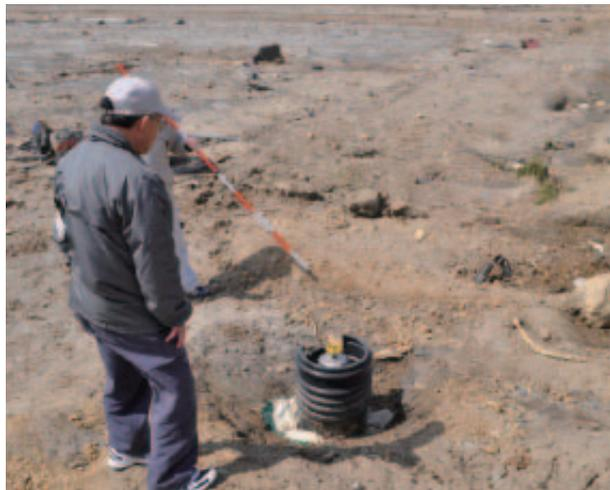
津波による灌漑用水パイプライン田区取水施設被災状況（陸前高田市）
