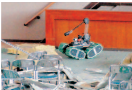
天井が一部崩落した八戸市内の体育館での移動ロボット KOHGA3 による調査
