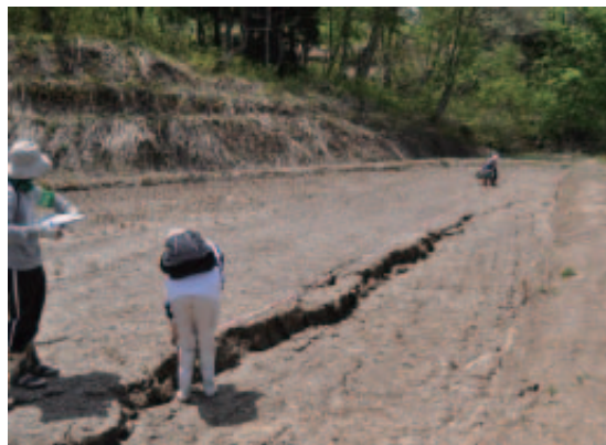
農地のクラック（地割れ）調査
