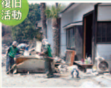
がれきの撤去運搬を行う学生
