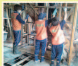
壊れた建物の復旧を行う 学生ボランティア
