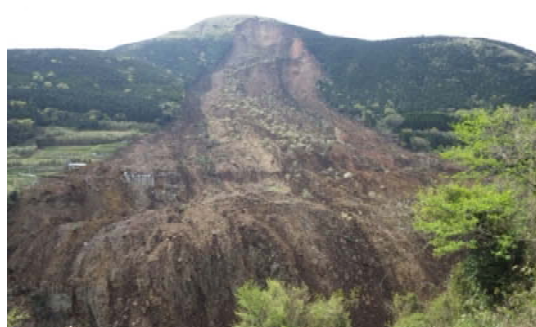
熊本地震により発生した阿曾大橋付近の大規模な斜面崩壊（H28.4.16撮影）
