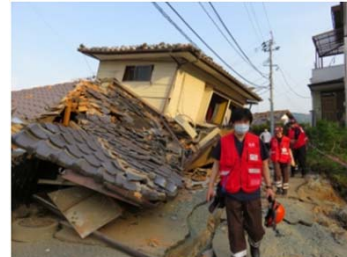
益城町の被災状況視察の様子（20日午後）
