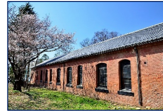
↑「旧松本歩兵第五十連隊糧秣庫(通称:赤レンガ倉庫)」
