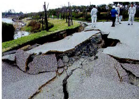
地震発生後に行った現地調査（地震により陥没した道路）
