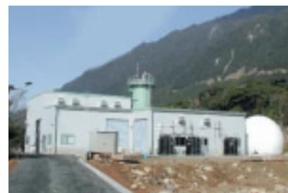
有機系廃棄物の複合資源化 システムパイロットプラント (鹿児島県屋久町)
