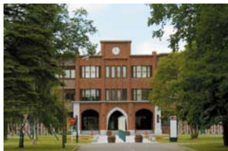
総合研究棟I号館風景
