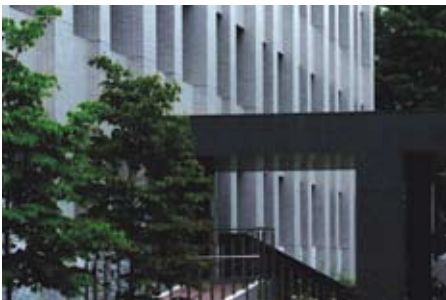
医学部基礎研究棟（昭和キャンパス）
