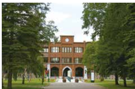
総合研究棟I号館
