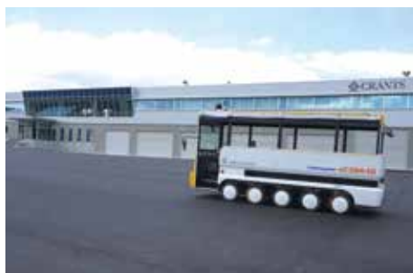
自動運転研究施設・次世代モビリティ社会実装研究センター外観(2018年5月竣工)
