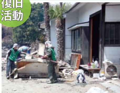
がれきの撤去運搬を行う学生
