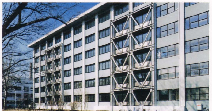
▲ 耐震補強を行って、安全性を確保した建物。
