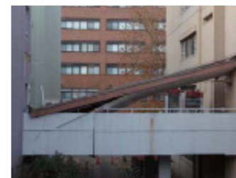
連絡通路の屋根崩落
