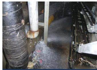
配管の破損による水漏れ
