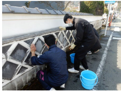
松崎町の伝統的な「なまこ壁」の保全活動
