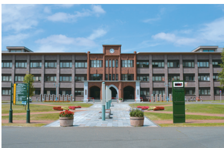
総合研究棟I号館
