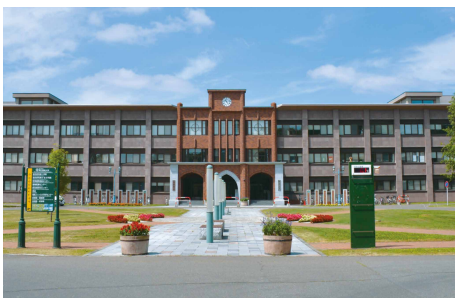
総合研究棟I号館
