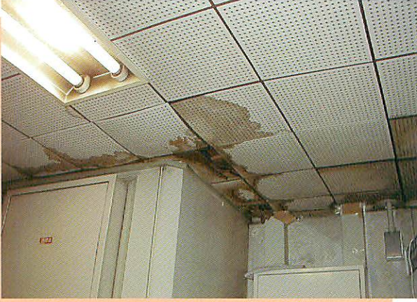
■写真1：内装(天井)
