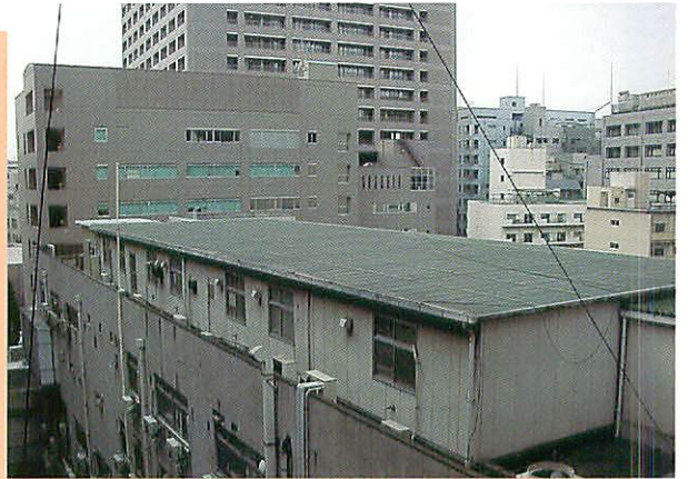
■写真4：研究施設(仮設建物)
