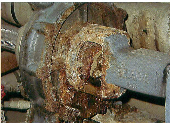
■写真5：ポンプ室
