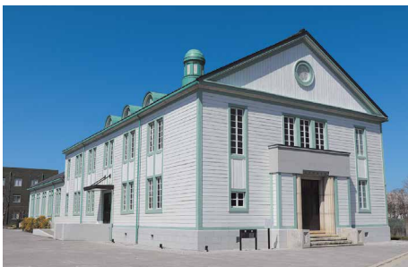
雄大な琵琶湖と歴史ある彦根城に囲まれた彦根キャンパスの滋賀大学講堂(登録有形文化財)
