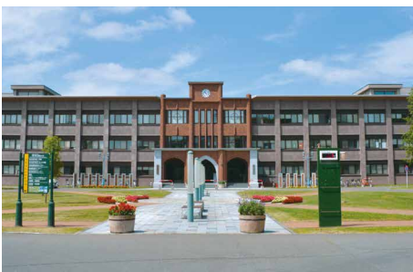
総合研究棟I号館
