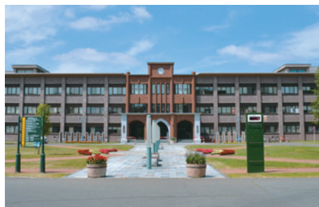
総合研究棟I号館
